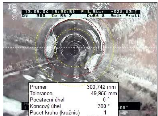
Obr. 17 99,5 m Vrstání kořenů vpravo
