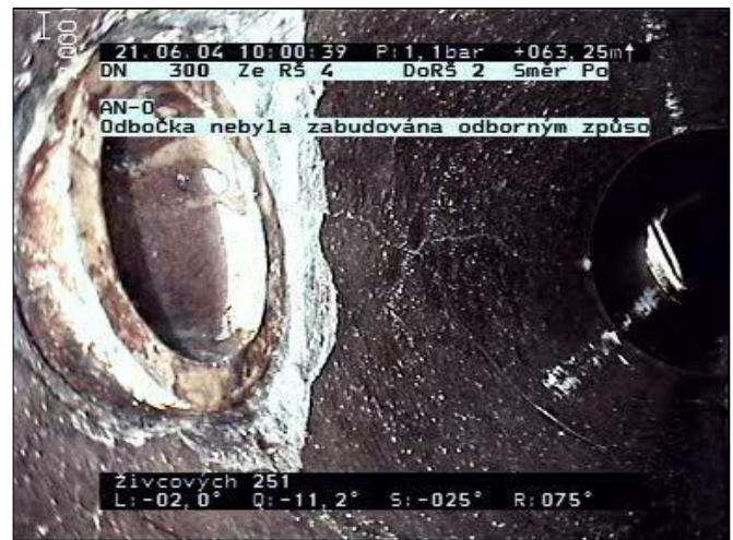
Obr. 15 63,3 m Odbočka nebyla zabudována odborným způsobem ve vrchní části (v závěru)
