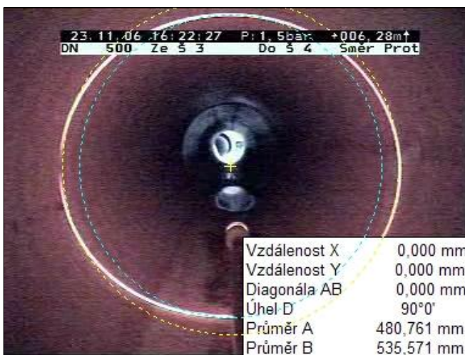
Obr. 30 6,3 m Deformace 5,40 %
