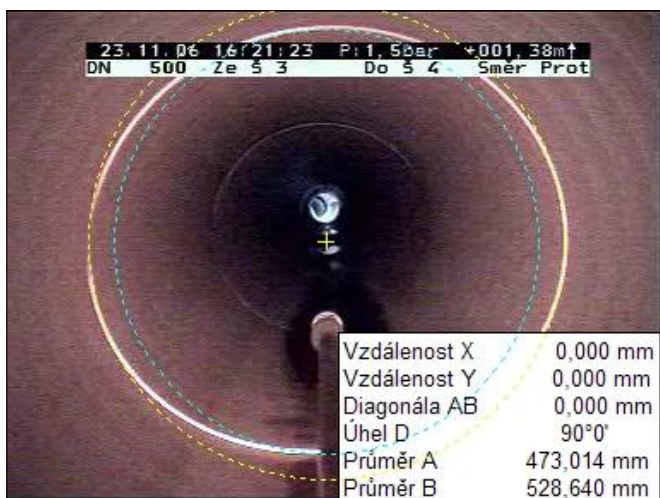
Obr. 29 1,4 m Deformace 5,50 %
